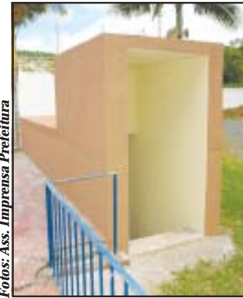
Construção da casa de máquinas
