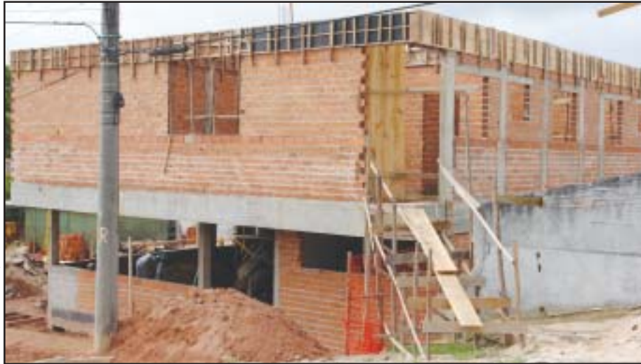
Obras no segundo pavimento está em fase de finalização
